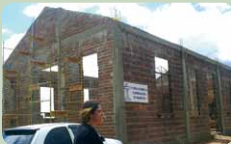
Templo em construção em Bananeiras.
